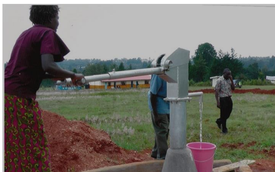
Brunn och vattenförsörjning på skolan i Kiminini.
